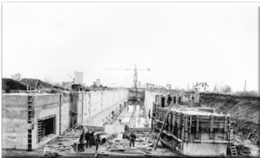
1963 - Construction du sas avec sur la gauche "entrée ou sortie de l'aqueduc" et dans le sas, les petits trous en bas à gauche "les larrons".
